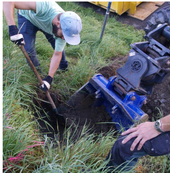
Abbildung 35: Nachdem mit der Schaufel in der richtigen Tiefe angesetzt wurde, konnten die Blöcke mit einem Spaten einfach abgetrennt werden. (Bild: Gregori, 2016)
