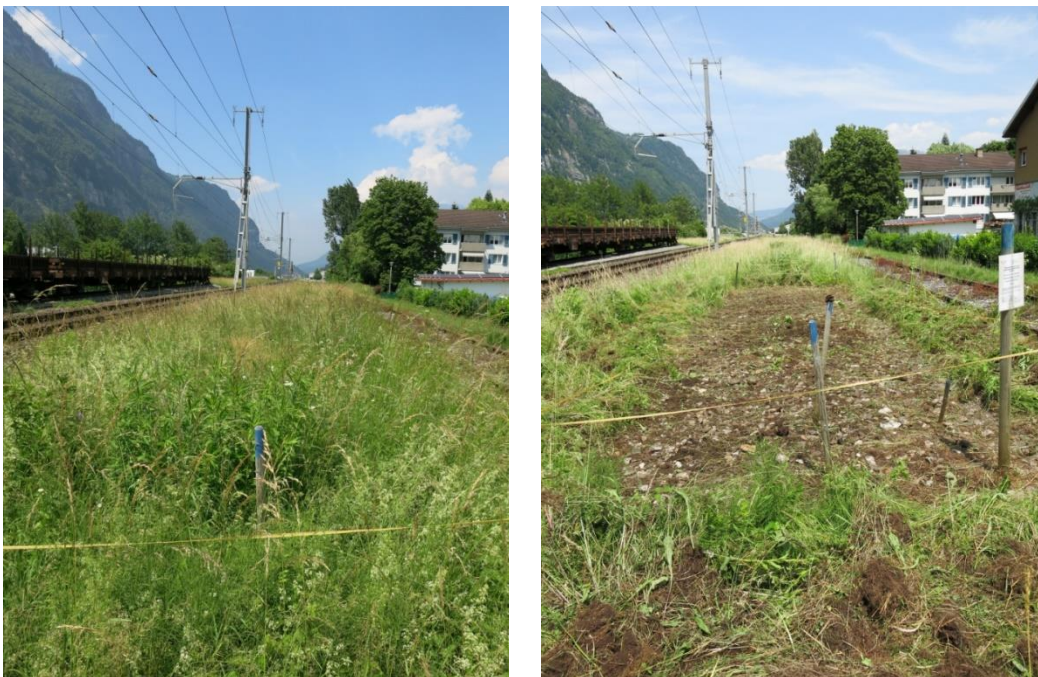
Abbildung 12: Der Standort Glarus 13 im Mai 2015 vor (Bild oben links) und nach (Bild oben rechts) dem Entfernen der Vegetation mitsamt der obersten Humusschicht. (Bilder: AWEL, 2016)
