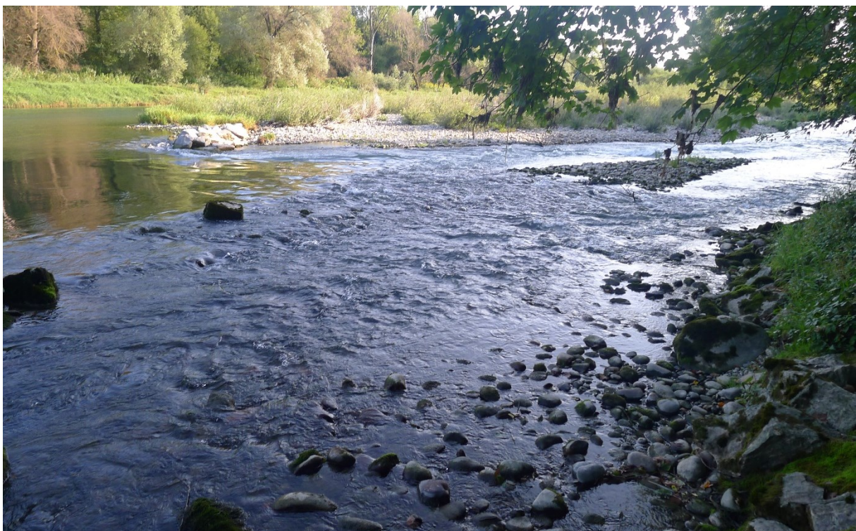
Abb. 28 Aare, Restwasserstrecke flussabwärts des Hilfswehrs (GEWISS km 22.0) mit vielfältigen Strukturen und befestigtem Ufer (2015).
