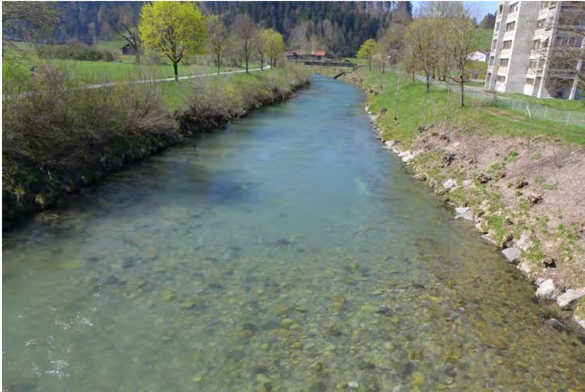
Abb. 36 Thur ab Brücke Waisenhausstrasse (GEWISS km 39.9) mit schmaler, ausgeräumter Sohle sowie steilen und strukturarmen Ufern (2015). Blick flussaufwärts.
