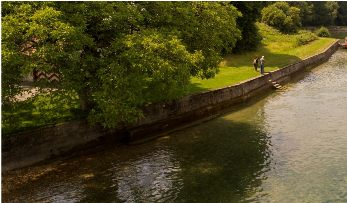
Abbildung 4-6: Betonmauer im Bereich Restaurant Schupfen mit auf Mauerkrone verlaufendem Wanderweg
