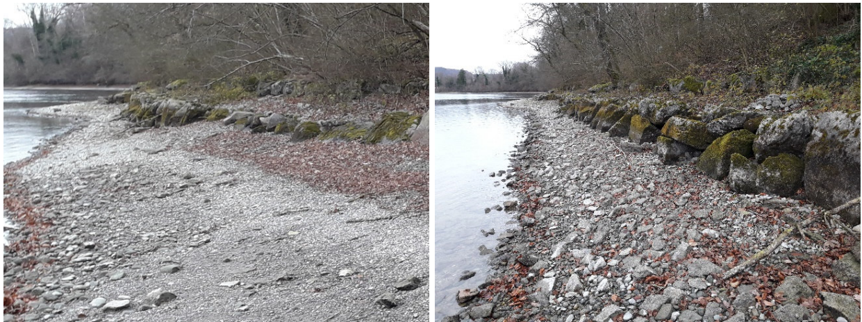
Abbildung 4-4 Blockwurf oberhalb Schupfen aus Granit
