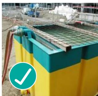
Absetzbecken mit Gitterrost, Einleitung vor der Prallwand/Tauchwand
