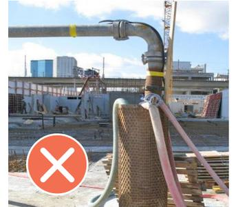
Keine Einleitung von Baugrubenabwasser ins Grundwasser!
