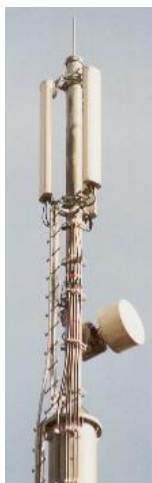
Mobilfunkantennen (länglich)
