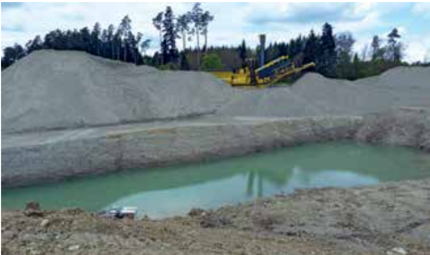
Oben: Einbau von unverschmutztem Aushub in einer Kiesgrube in Hohentannen
