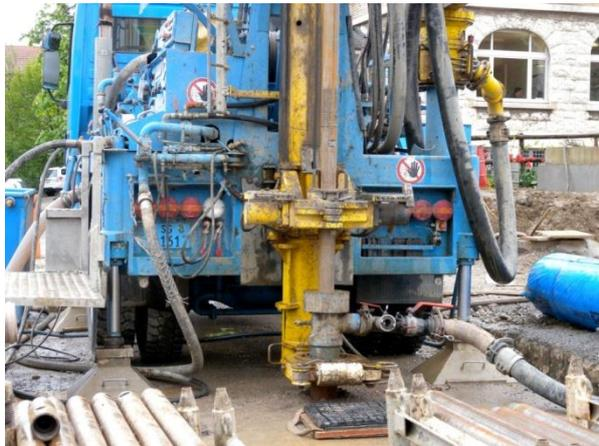
Abb. 1: Erdwärmesondenbohrung Bruggen, St.Gallen
