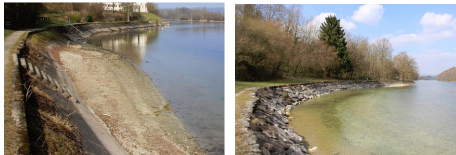
Abb. 3 Typischer Uferverbau entlang des Thurgauer Rheinufers, links: Betonelemente bei Wagenhausen, rechts: Blocksatz beim Schupfen in Diessenhofen
