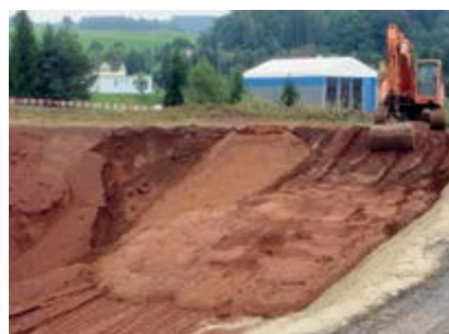
Bild: Zwischenlager phosphorhaltiger Asche, Deponie Burgauerfeld, Flawil
