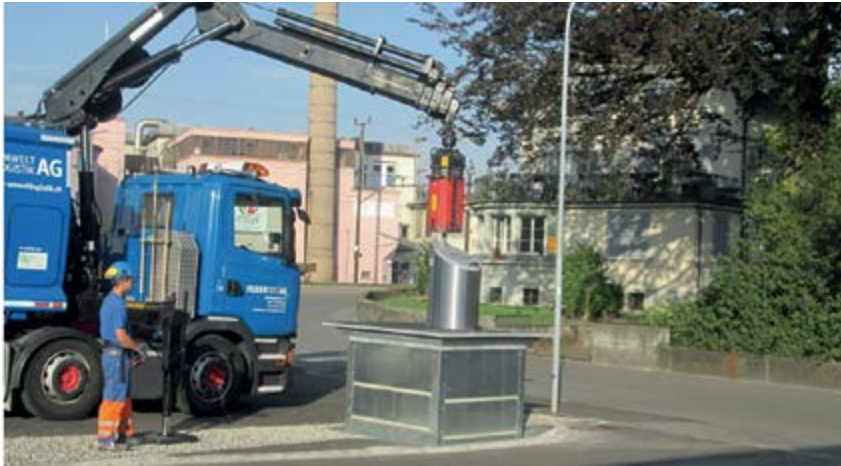
Bild: Leerung eines Unterflurcontainers
